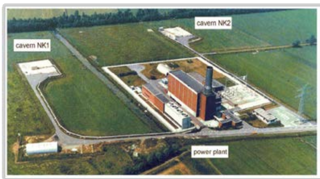
Fig.IV.III: Impianto CAES di Huntorf (Germania) [16]
