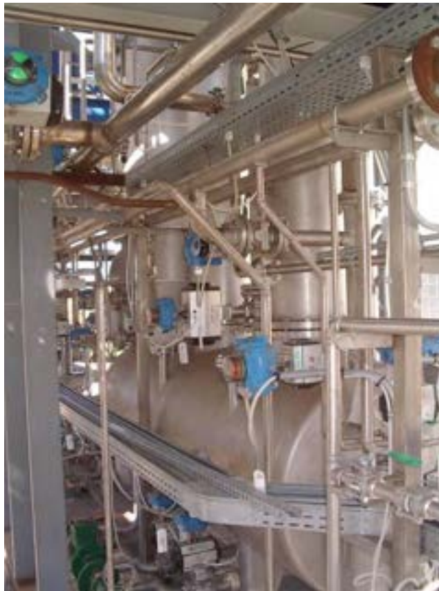
Figura 2.2. Sistema di lavaggio del syngas.
