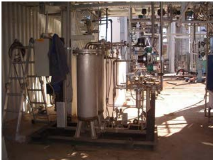
Figura 2.9. Il sistema PSA per la purificazione dell’idrogeno.
