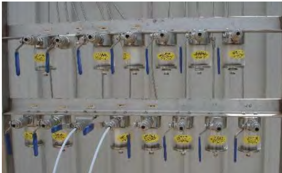
Figura 2.12. Pannello collettore delle prese di campionamento.
