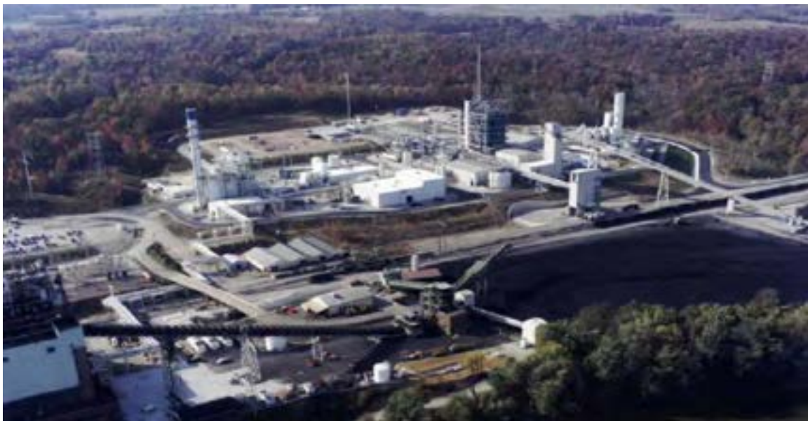
Figura 4.17. Impianto IGCC di Wabash River 38 .
