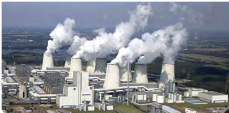
Figura 9.6. La centrale Vattenfall di Jämschalde 112 .
