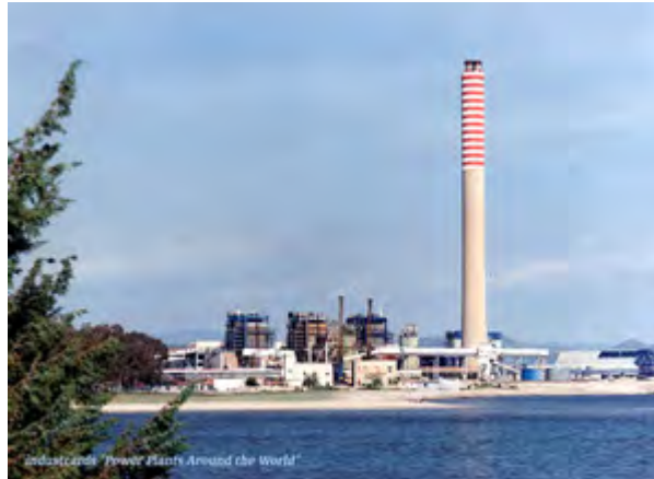
Figura 4.10. Centrale Enel “Grazia Deledda” presso Portovesme, nel Sulcis 29 .
