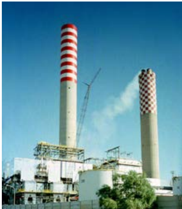
Figura 5.3. Impianto SNOX TM da 1,2 \cdot 10^6 Nm 3 /h presso la raffineria di Gela 62 .
