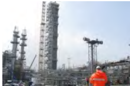
Figura 9.7. L'impianto di Mongstad, in corso di costruzione 115 .
