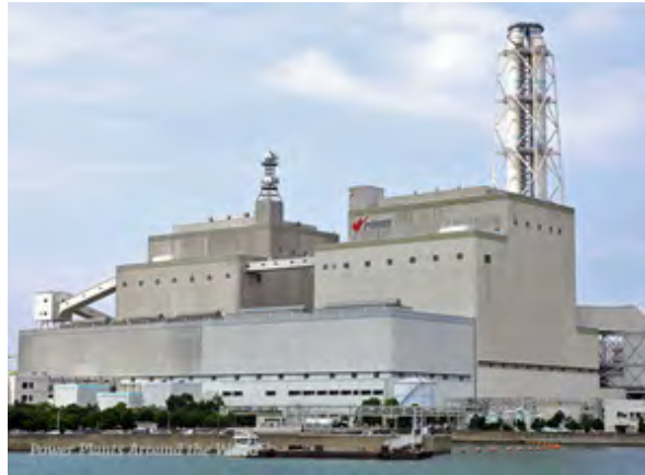
Figura 4.4 Impianto ultrasupercritico Mitsuura della J-Power, in Giappone 15 .
