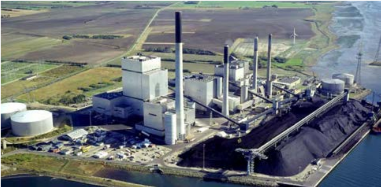
Figura 4.7. Impianto ultrasupercritico Nordjyllandsværket unit 3 21 .
