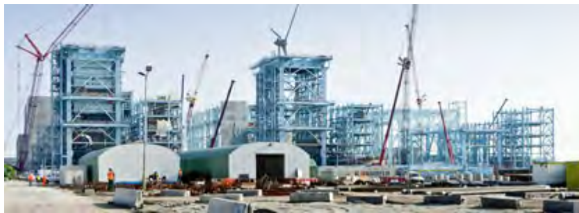
Figura 9.8. L'impianto Nuon di Eemshaven, in corso di costruzione 116 .
