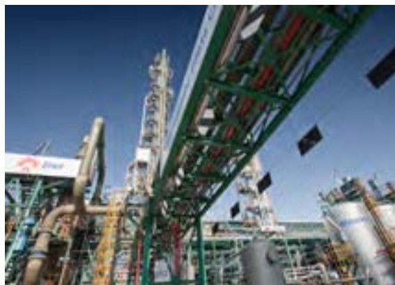
Figura 9.4. Impianto pilota presso la centrale Enel Federico II di Brindisi 106 .
