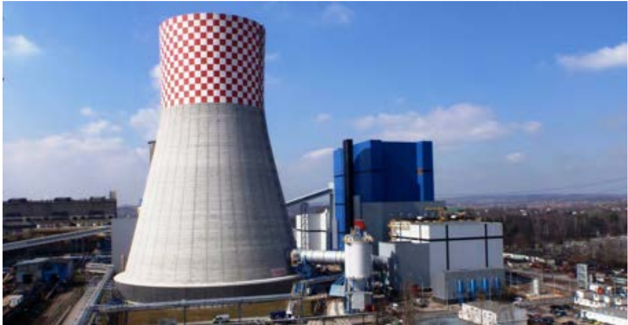
Figura 4.9. Impianto AFBC a ciclo supercritico di Łagisza 28 .
