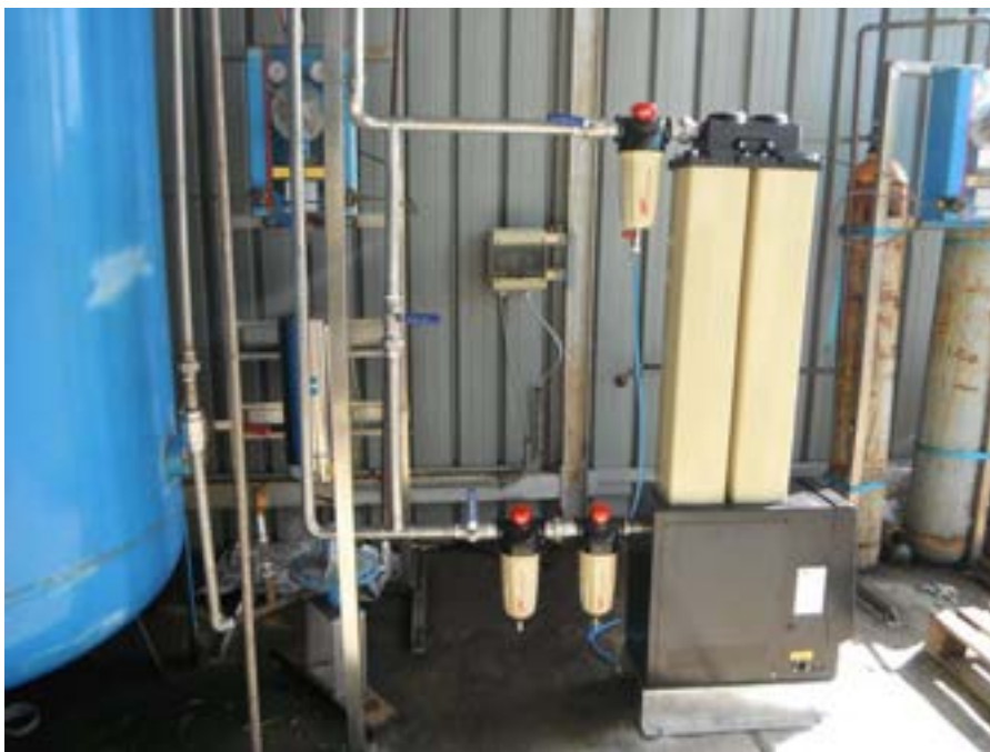
Figura 2.2.1: Sistema di trattamento aria processo
