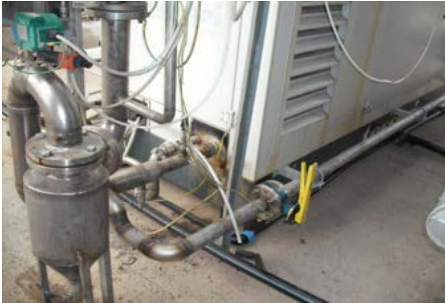
Figura 2.4.1.2: Piping di collegamento gasometro – motore
