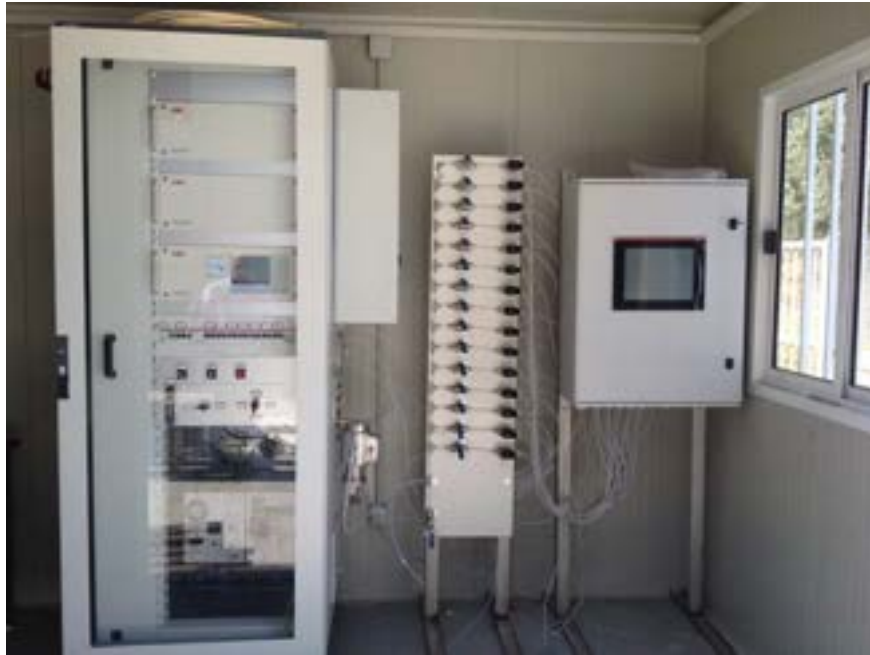
Figura 10 – Sistema di analisi online del syngas
