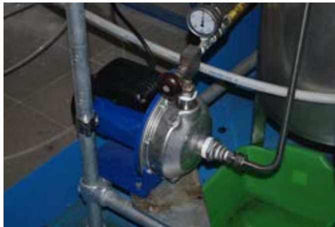
Figura 2.9. Sistema di rilancio del solvente in colonna.
