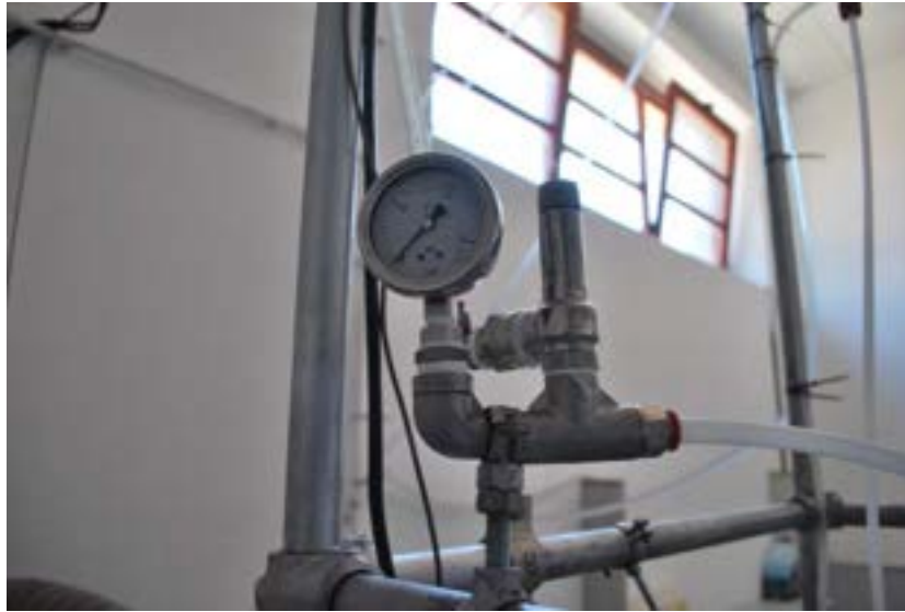
Figura 2.13. Manometro e valvola di sicurezza.
