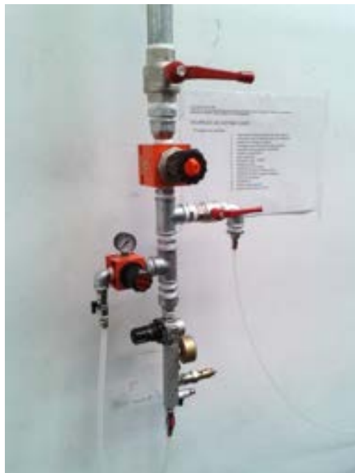
Figura 2.6: Particolare della parte terminale dell'impianto di aria compressa del dipartimento, sul quale sono montati i regolatori di pressione e le valvole a sfera (posizioni 1, 2, 3, 6, 8).
