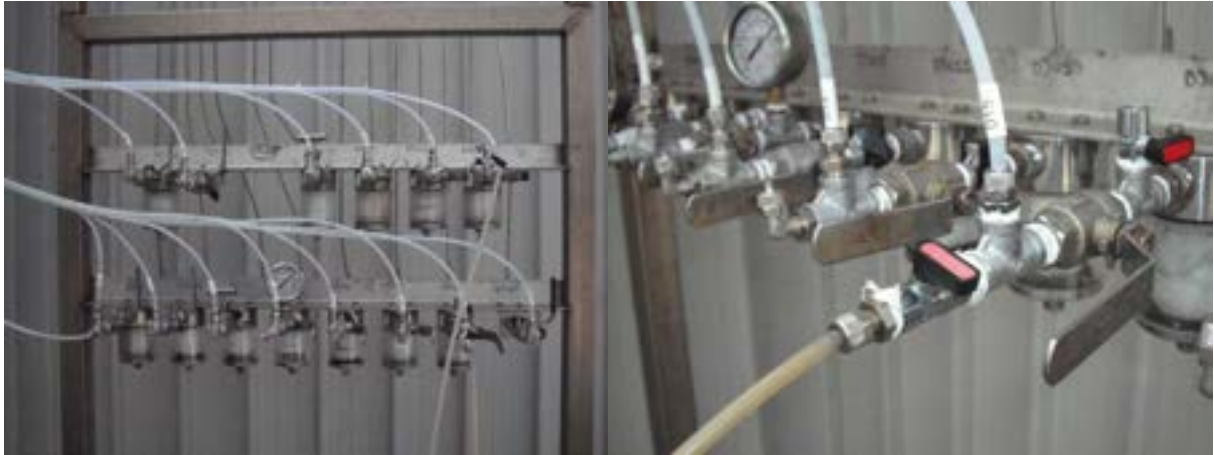
Fig. 21 – Adeguamento rastrelliera di raccordo punti di campionamento gas
