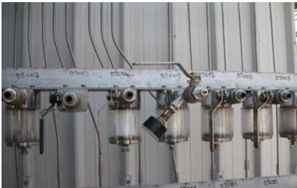
Fig. 17 – Inserimento raccordo Swagelok e manometro nella presa di campionamento DJ005
