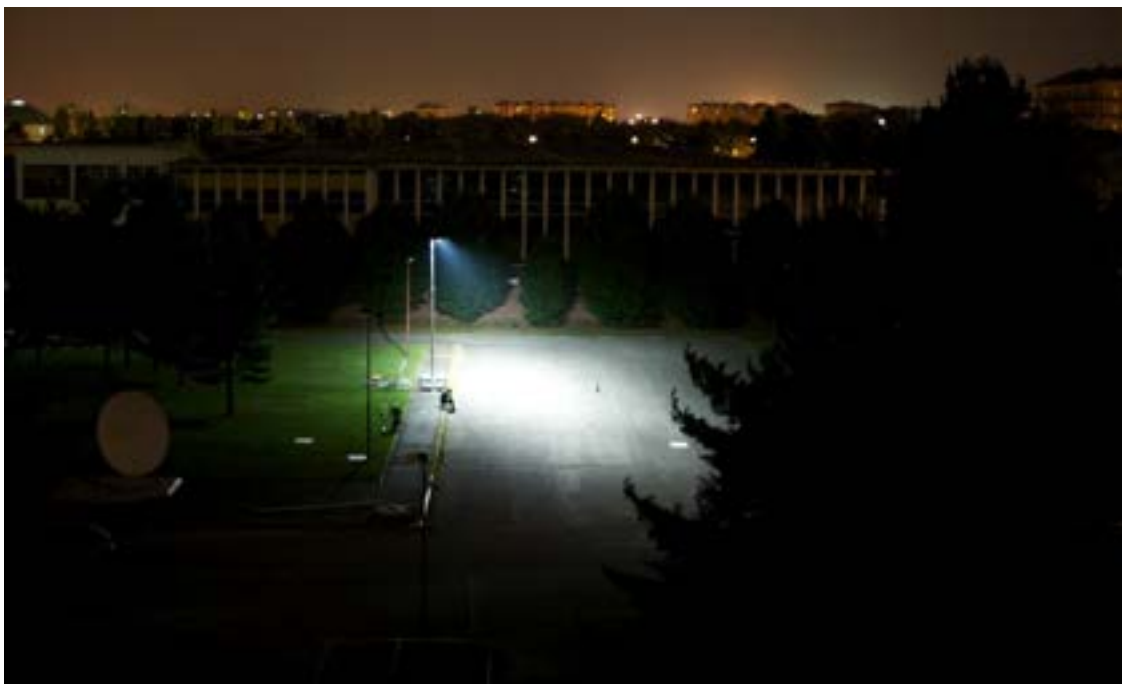
Figura 68 Impianto con apparecchio con vetro piano e con sorgenti LED – primo esempio di acquisizione dall’alto – immagine fotografica.
