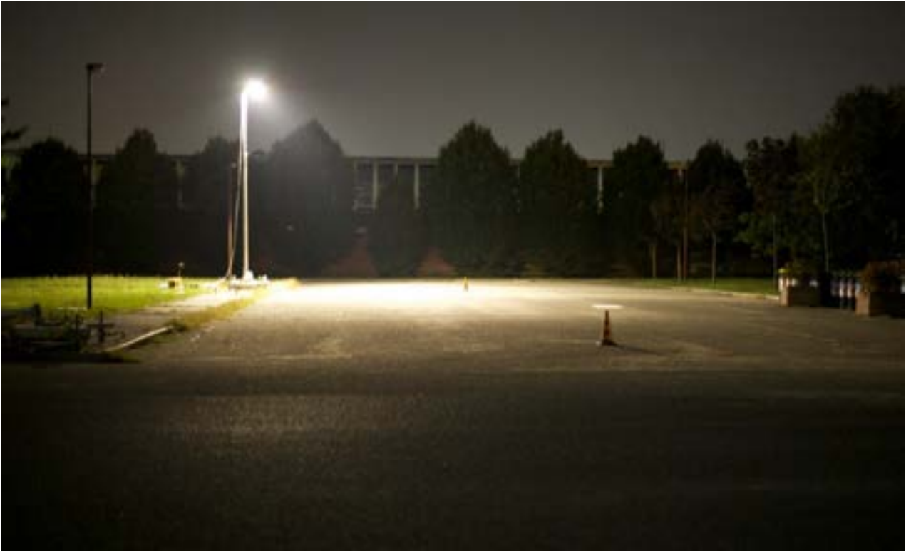
Figura 56 Impianto con apparecchio con vetro curvo e con lampada a ioduri metallici.
