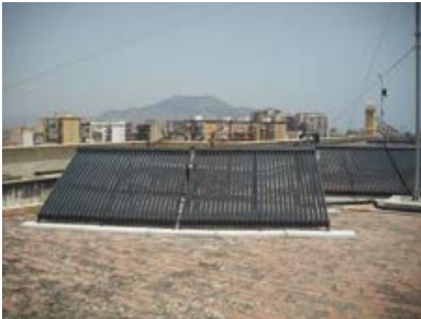
Figura 40: Campo solare con area di apertura totale pari a 44.7 m 2 e costituito da 4 collettori solari Thermics DTH 20 e 25 collettori solari Tsinghua SLU 1500
