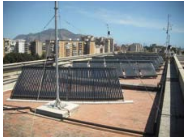
Figura 40: Campo solare con area di apertura totale pari a 44.7 m 2 e costituito da 4 collettori solari Thermics DTH 20 e 25 collettori solari Tsinghua SLU 1500
