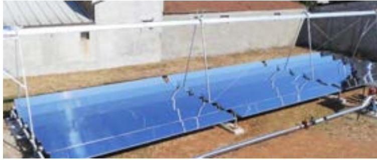
Figura 32 Concentratore a riflessione Fresnel [29]
