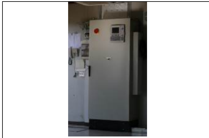
FIGURA 1.74: Quadro elettrico e pannello del sistema Eistein
