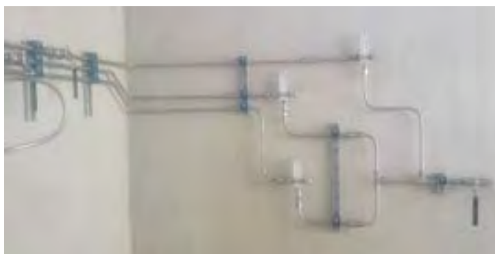
Figura 3.6. Circuito di alimentazione gas: flussimetri e valvole di sezione.
