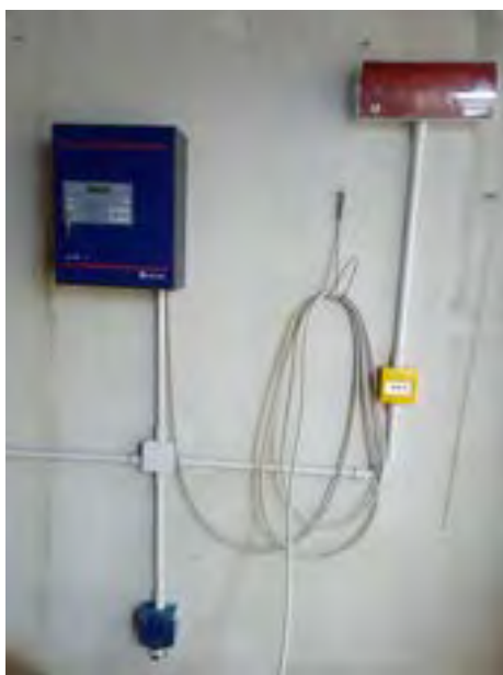
Figura 3.7. Componenti del sistema di rilevazione H2S.
