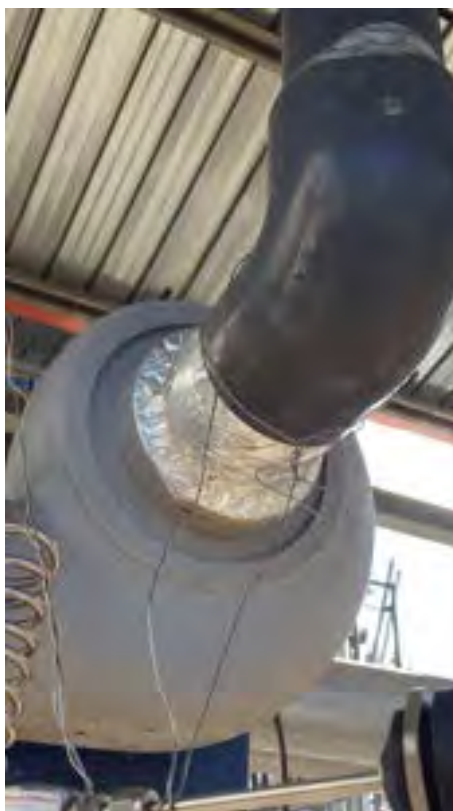
Figura 3.2. Sigillo canale di aspirazione.
