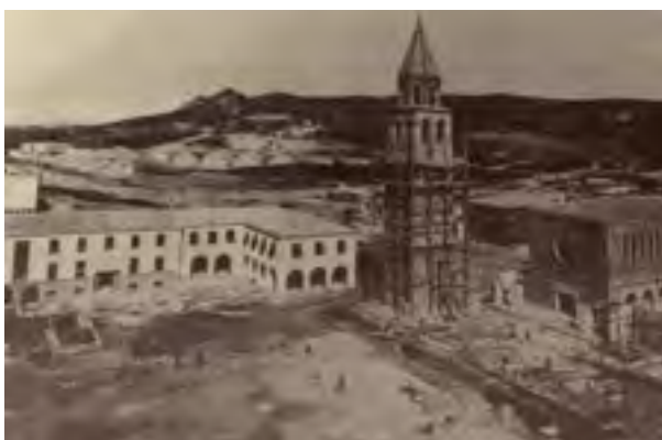
Foto 5.1.2 Facciata principale del municipio durante la costruzione.
