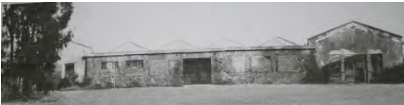
Figura 6.1.1 Facciata principale della struttura prima dell'intervento di ripristino.
