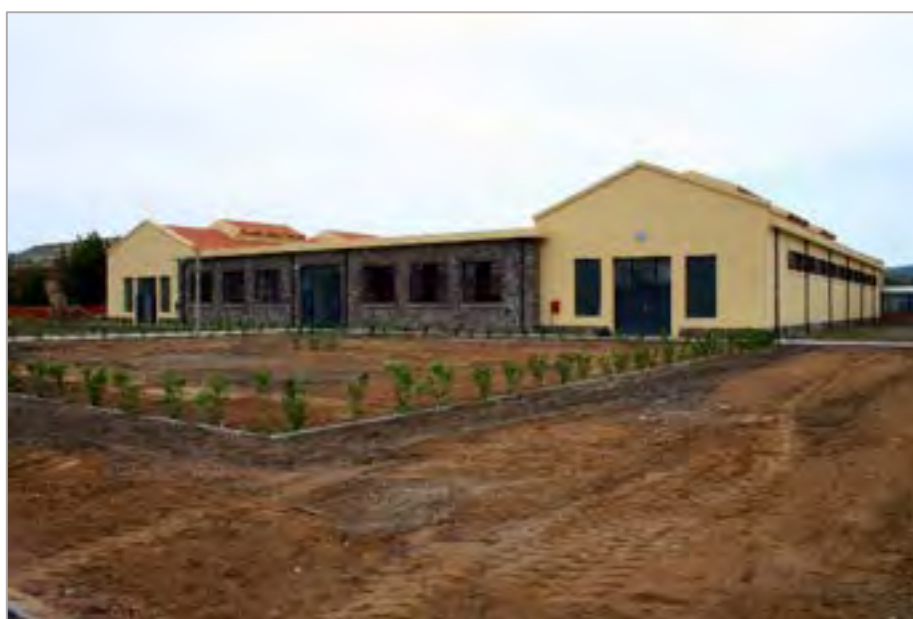
Figura 6.1.2 Facciata principale della struttura dopo l'intervento di ripristino per il riuso.
