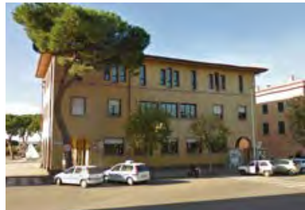
Figura 5.1.5 Immagine attuale dell'edificio ex-ufficio postale, ora accorpato al Comune.
