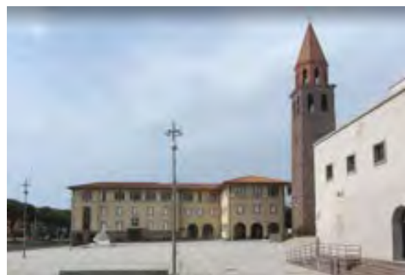
Foto 5.1.3 Facciata principale del municipio oggi.
