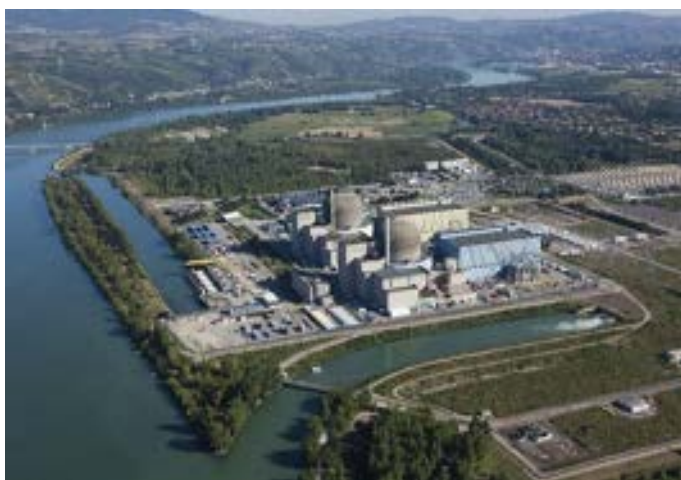
Figura 18 – Vista della centrale di Saint Alban 19 .
