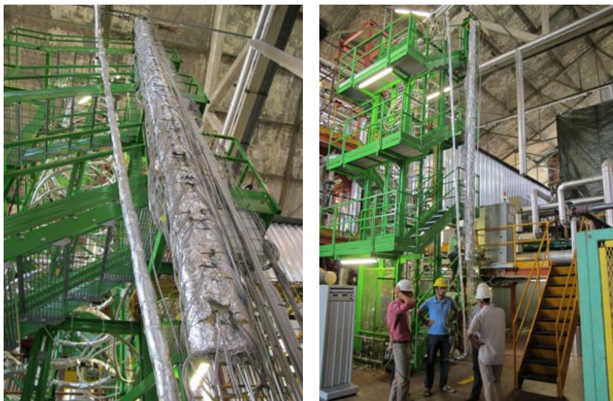
Figura 7 – Immagini della sezione di prova HERO-2 installata.
