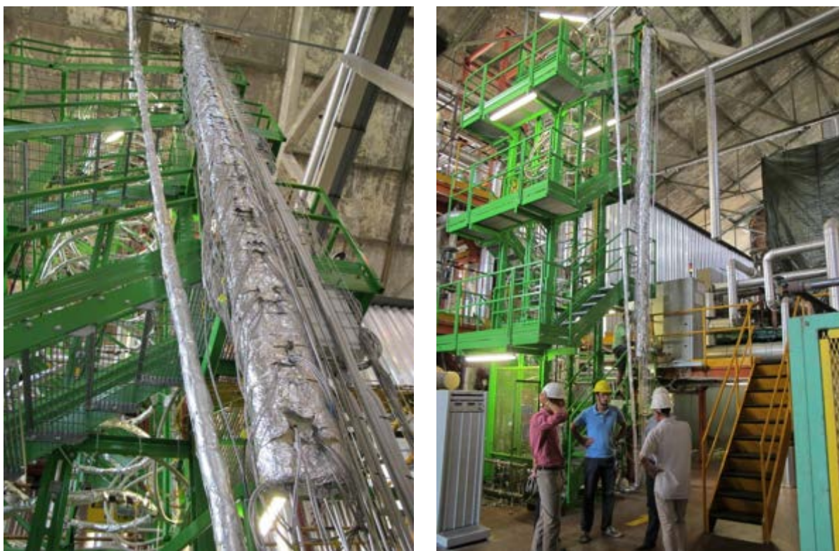
Figura 7 – Immagini della sezione di prova HERO-2 installata.
