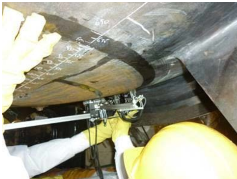
Fig. 23. Controllo di assenza di difetti mediante tecniche ad ultrasuoni (foto: EdF).
