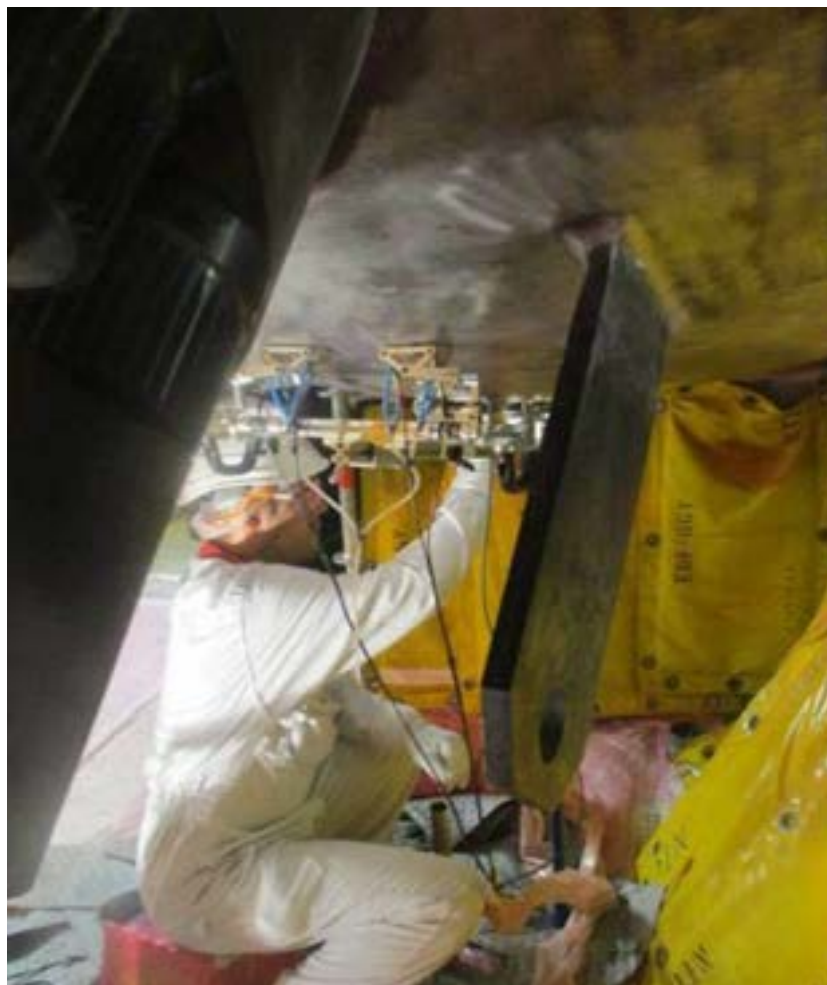
Fig. 25. Controllo di assenza di difetti mediante tecniche ad ultrasuoni (foto: EdF).
