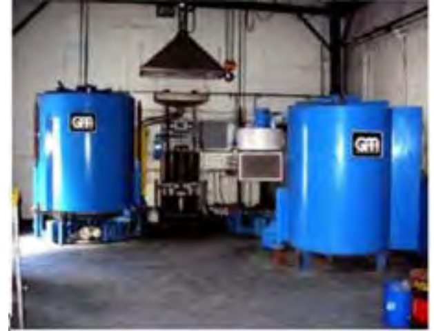
Un impianto industriale
