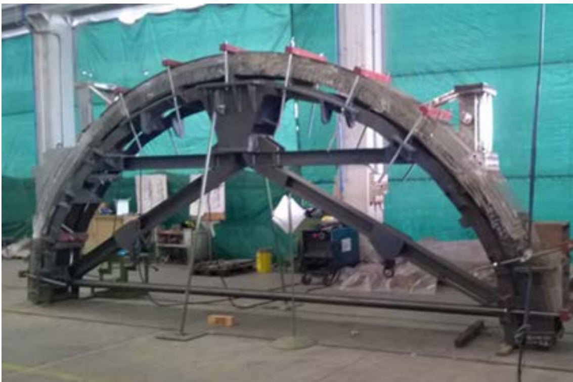
Figura 4: Saldatura dei supporti esterni alla gamba curva.
