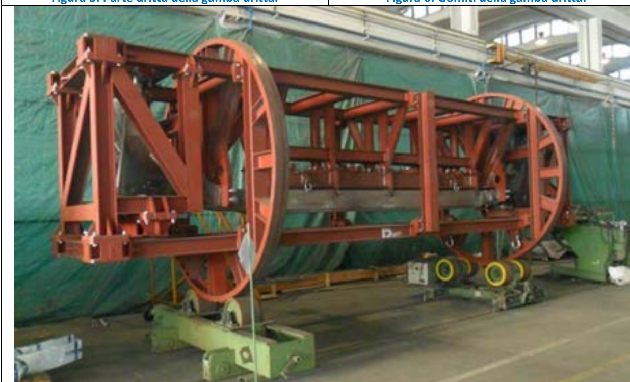
Figura 7: Saldatura dei gomiti sulla parte dritta della gamba dritta.
