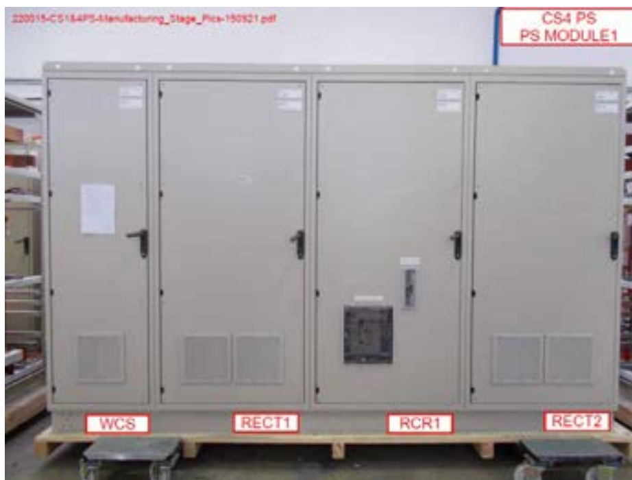
Figura 14 - Realizzazione del modulo 1 del CS4.
