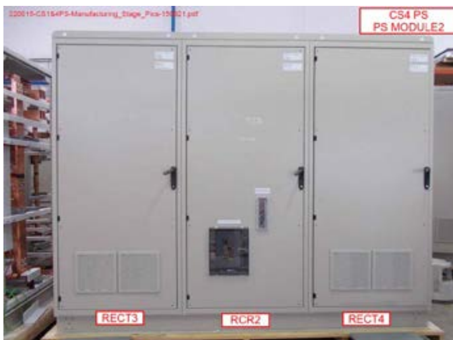
Figura 15 - Realizzazione del modulo 2 del CS4
