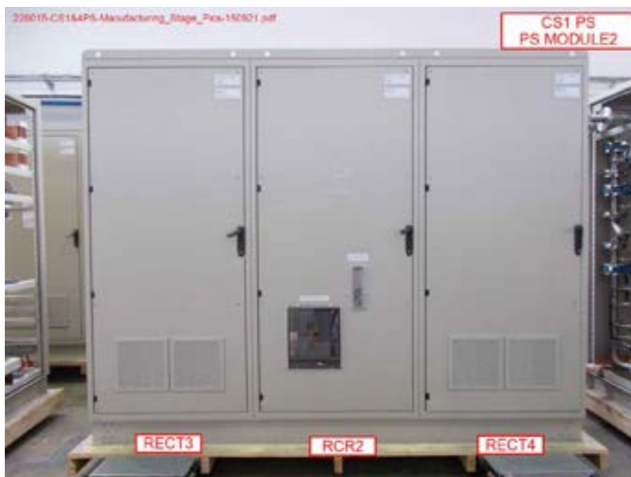
Figura 12 - Realizzazione del modulo 2 del CS1
