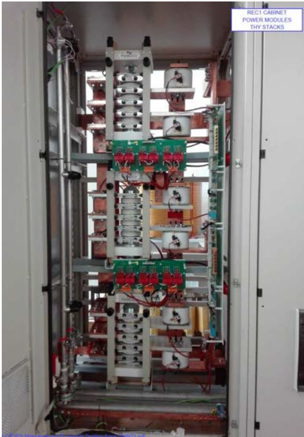
Figura 18 – Armadio con tiristori CS3.
