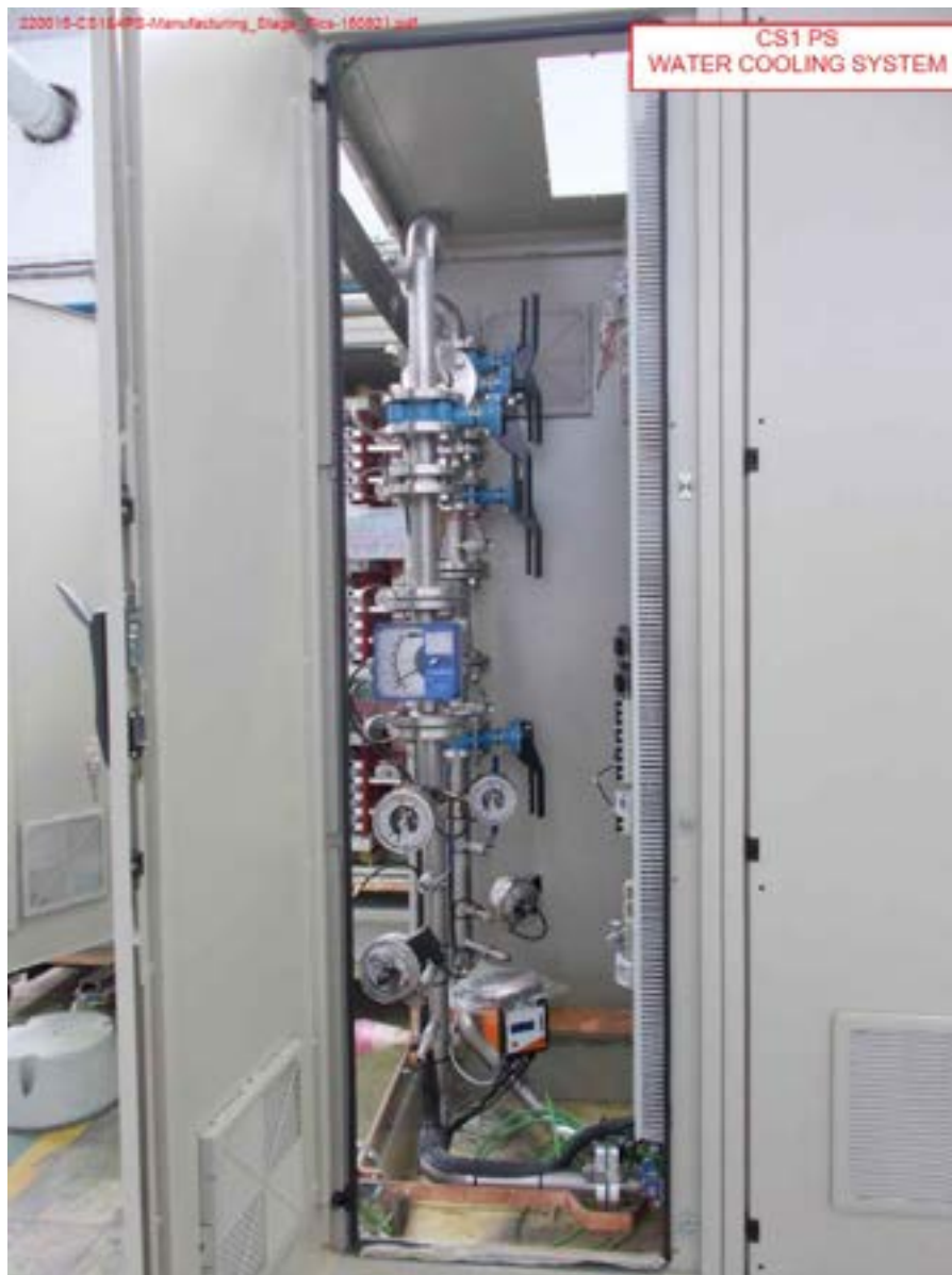
Figura 13 - Sistema di raffreddamento del CS1.
