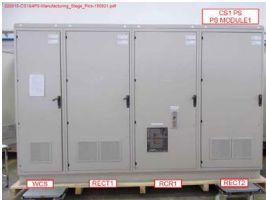
Figura 11- Realizzazione del modulo 1 del CS1.
