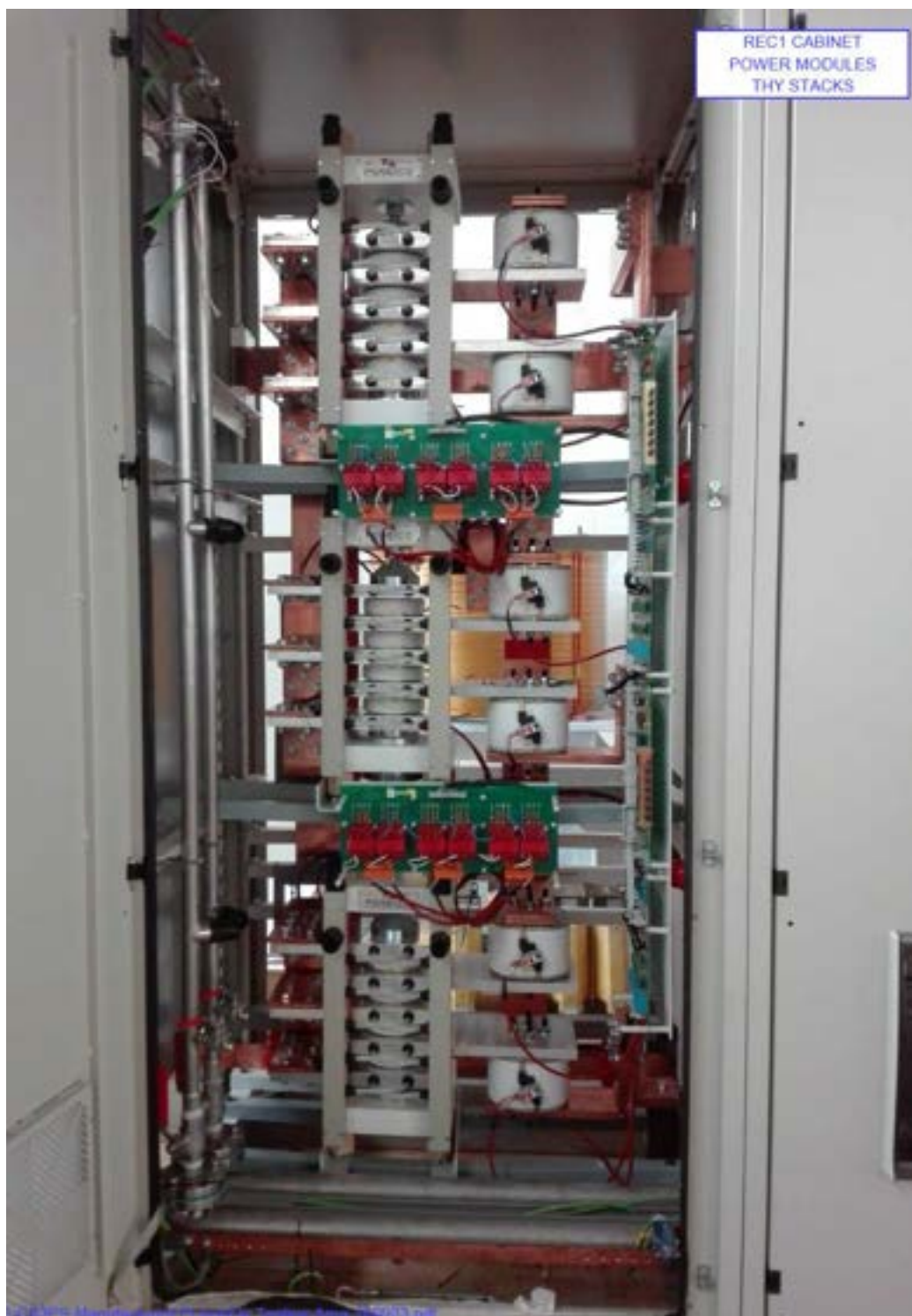
Figura 1 – Armadio con tiristori CS3.
