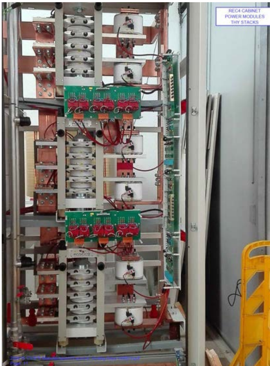
Figura 3 – Armadio 4 con tiristori CS3
