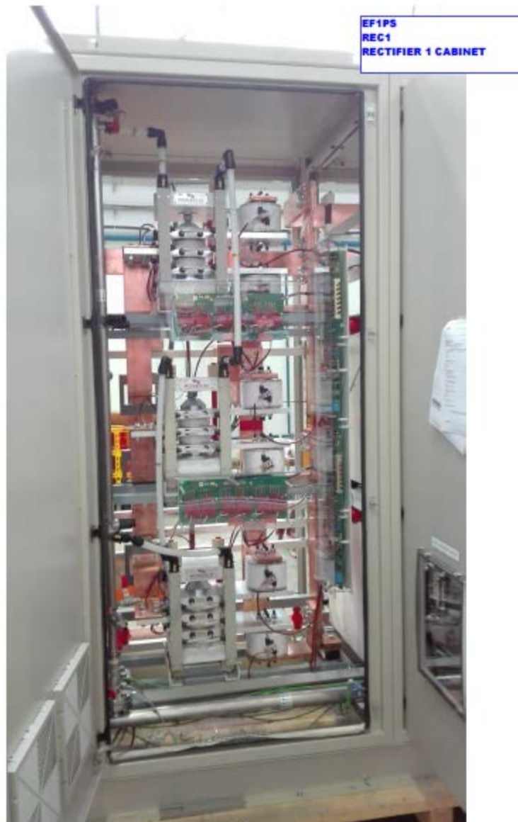
Figura 13 – Armadio 4 con tiristori EF1
