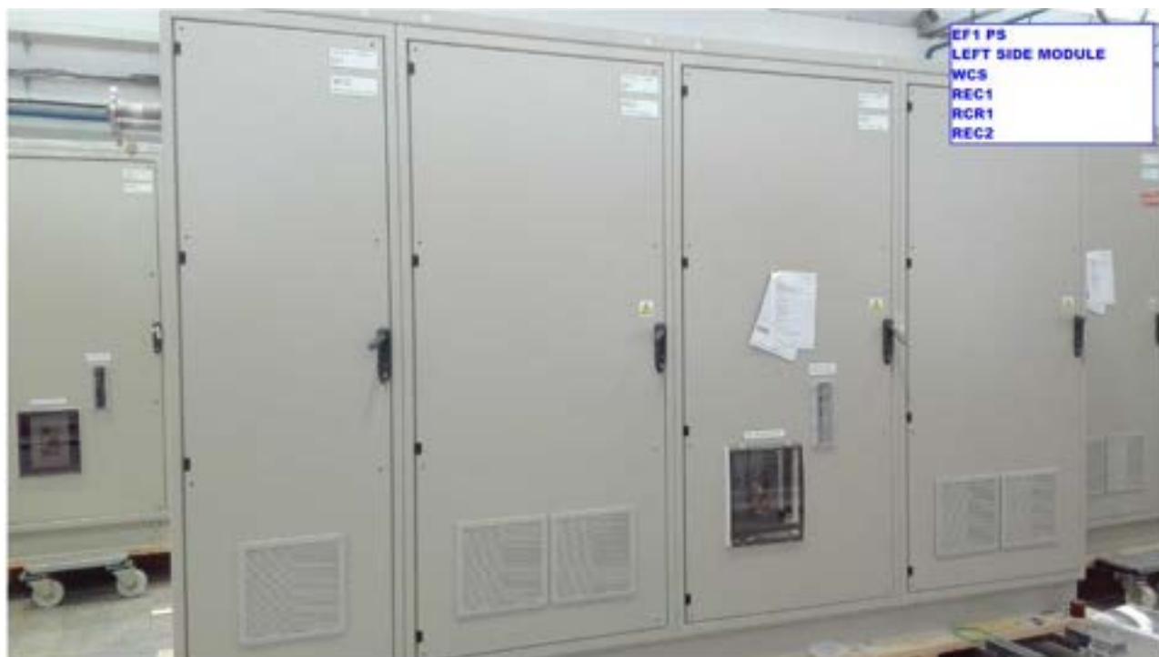
Figura 11 – Armadio con tiristori EF1.
