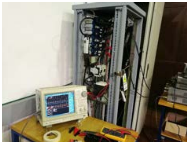
Figura 10 Strumentazione per la misura delle tensioni delle correnti e tensioni
