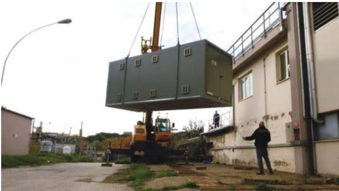
Figura 3. Box stoccaggio sicurezza batterie: griglie di ventilazione
