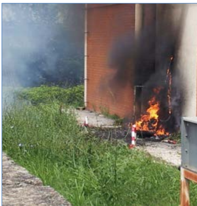
Figura 25. Rogo a seguito di test di overvoltage.
