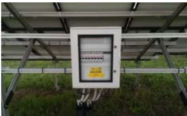
Figura 3. Quadro di campo dell’impianto monofase e trifase.
