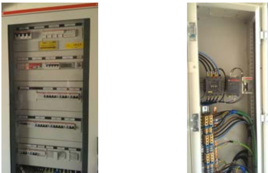
Figura 9. Il quadro Generale AC (sx) e il SPI (dx).
