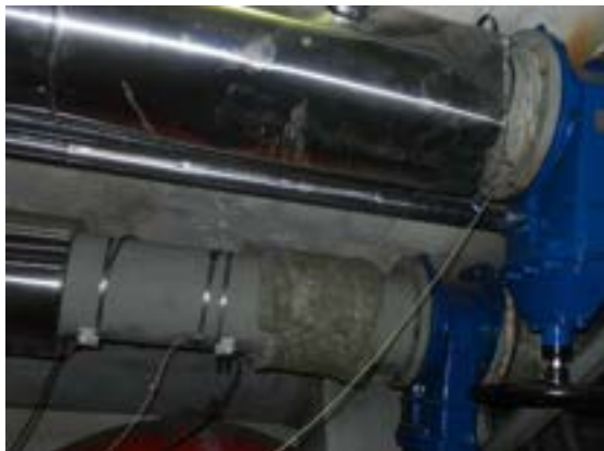
Figura 2. 19 - Installazione strumenti di misura
