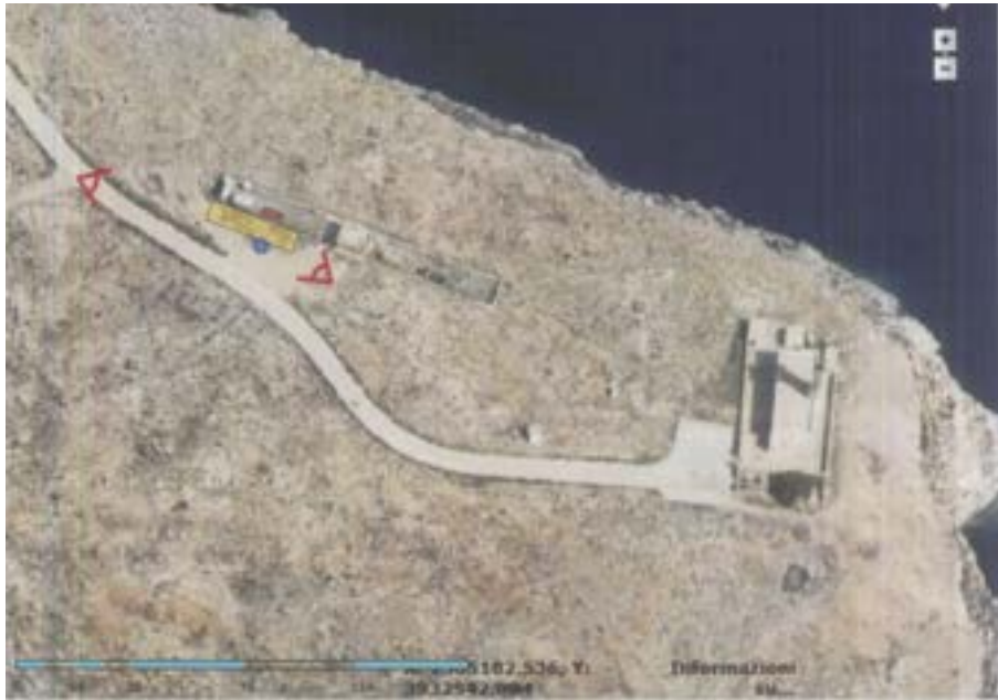
Figura 155. Ortofoto del sito su cui insiste la postazione ENEA presso il Faro di Capo Grecale dove verrà installato il sistema freesco.
