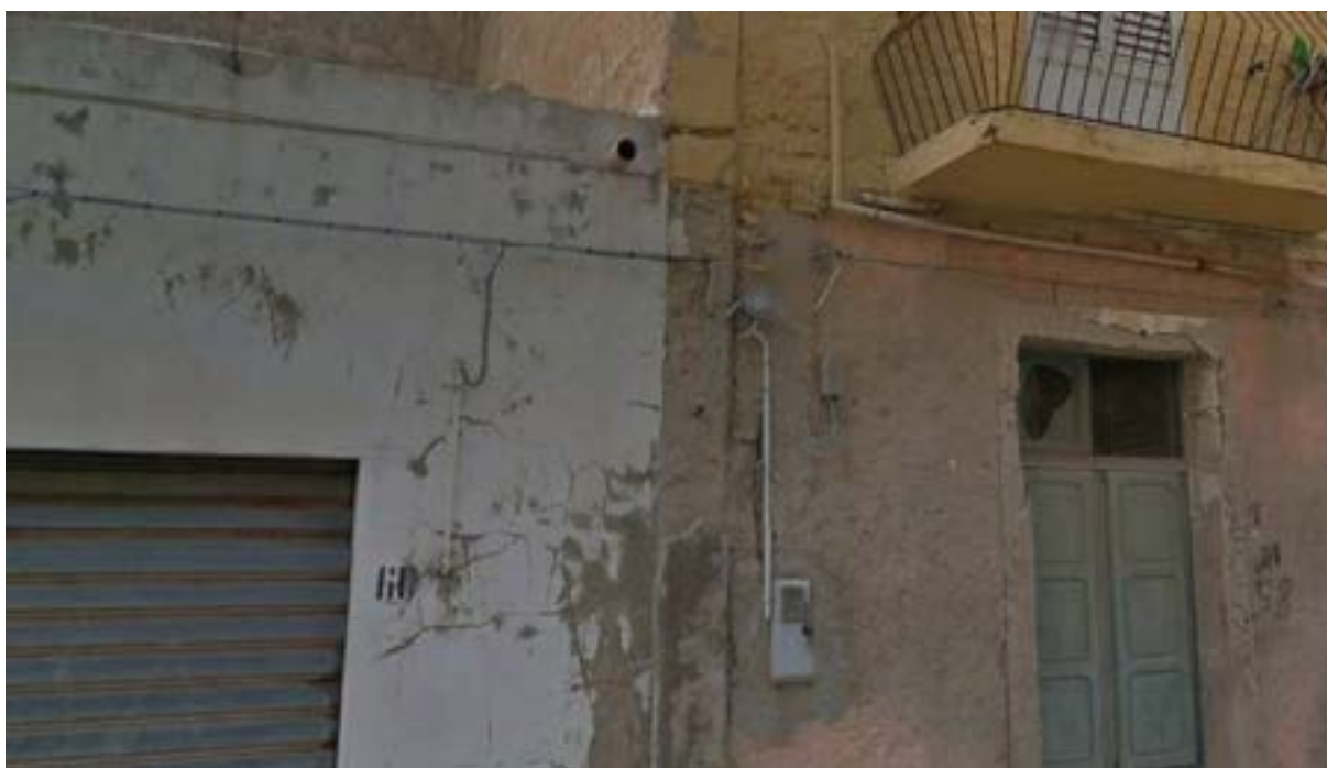
Figura 37. Particolare di linea in cavo aereo BT all'interno del centro urbano di Lampedusa.
