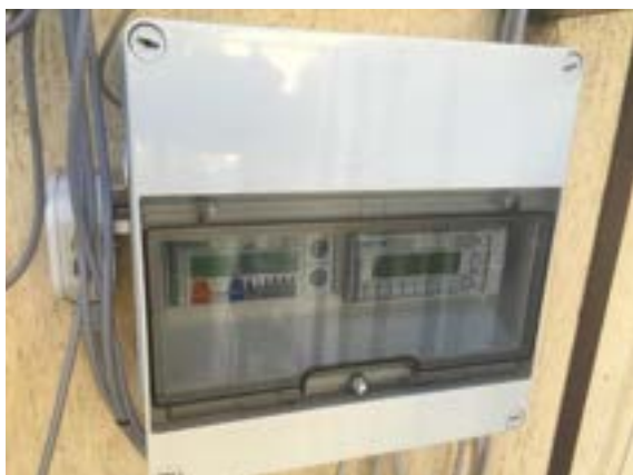
Figura 20: Installazione ITC-TC investigati (AP_3, AP_4, AP_5 e AP_6)
