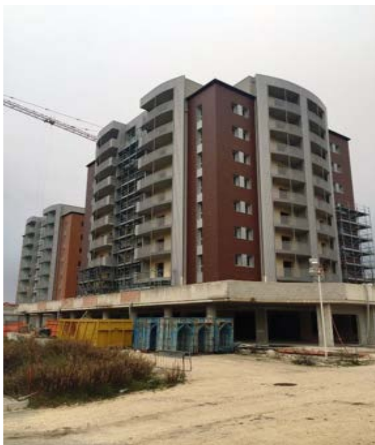
Figura 76. Stato dei lavori a marzo 2016
