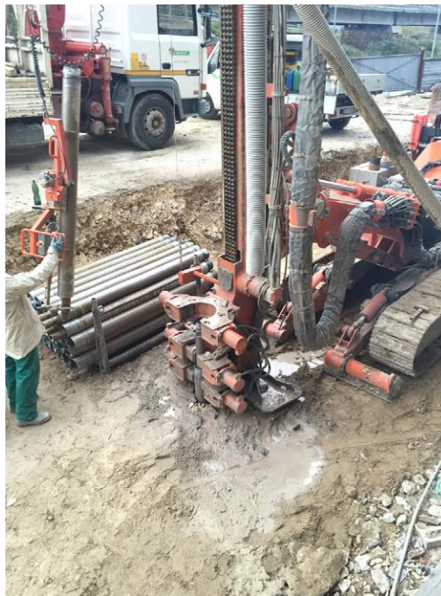
Figura 85. Fotografia dell'infilaggio di una sonda nel terreno.
