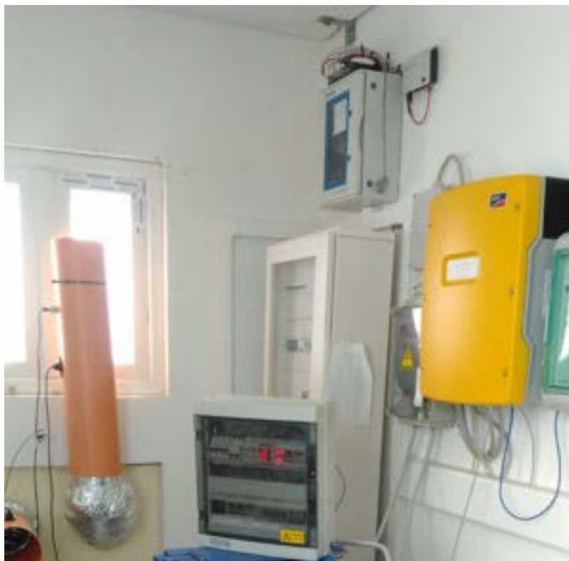
Figura 166: installazione quadro di misura con strumenti smart metering
