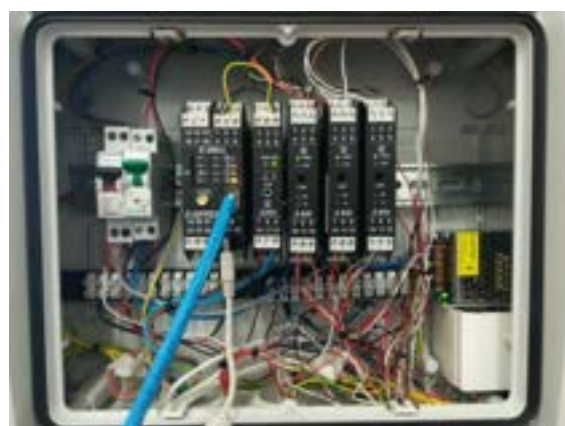
Figura 176 Sistema di monitoraggio installato a servizio dell'impianto freesco façade
