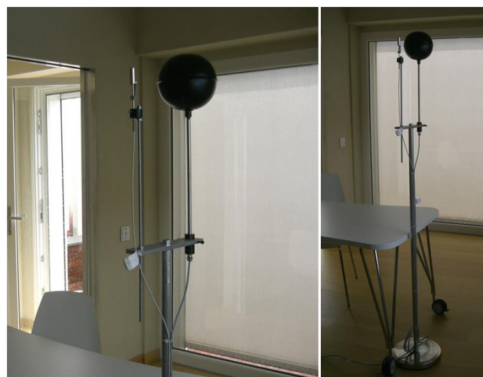
Figura 59. Sensori di temperatura dell'aria interna: termoresistenza PT100 e sonda globotermometrica.
