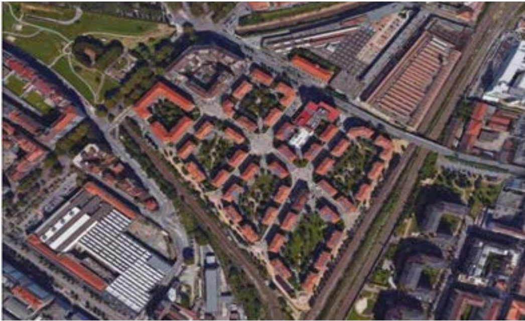
Figura 151 – Vista aerea della rete di teleriscaldamento di Torino (Arquata)
