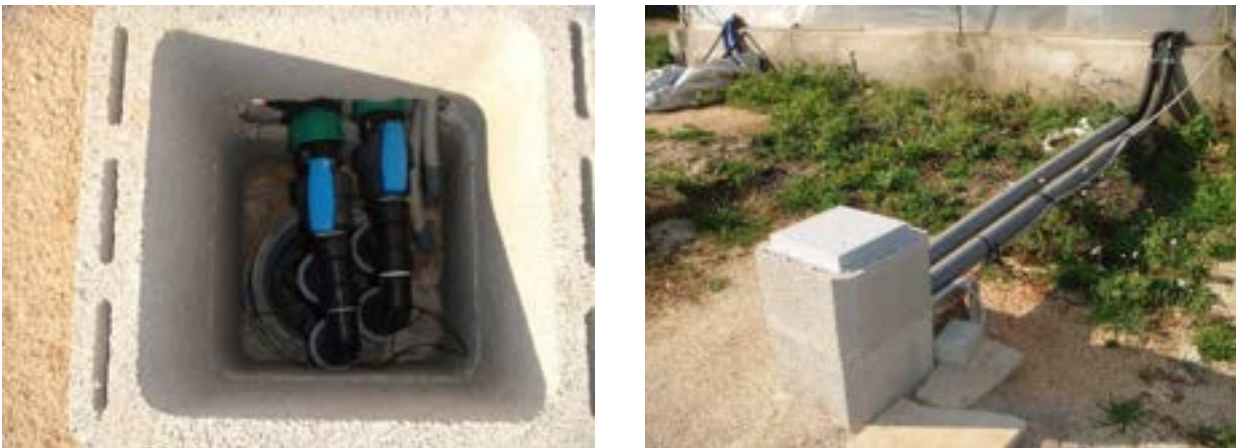
Figura 19: Ingresso nel suolo di sonda geotermica con scambiatori verticali presso il campo sperimentale dell'Università di Bari.
