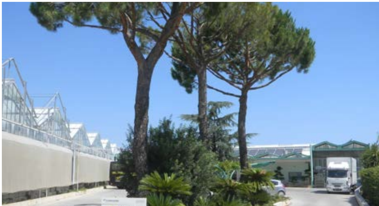
Figura 17: Pannelli solari fotovoltaici installati su superficie di copertura di locali accessori in un insediamento serricolo nel Sud Italia.
