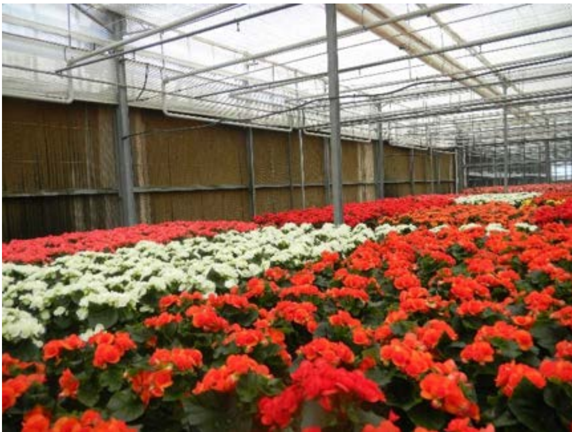
Figura 24: Sistema a filtri evaporativi: pannelli
