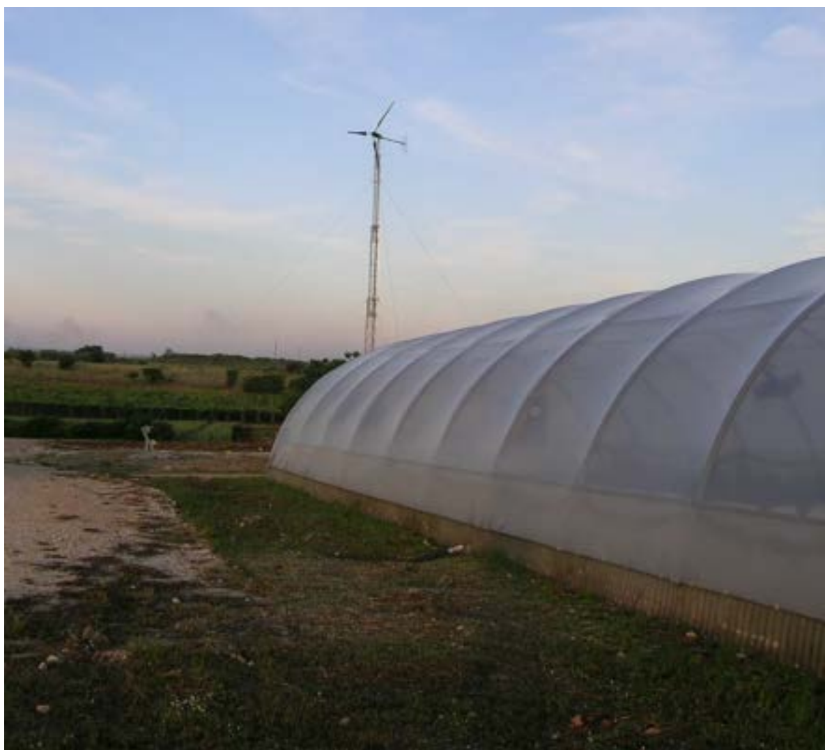
Figura 16: Generatore eolico di piccola taglia a servizio delle utenze elettriche in insediamento serricolo.
