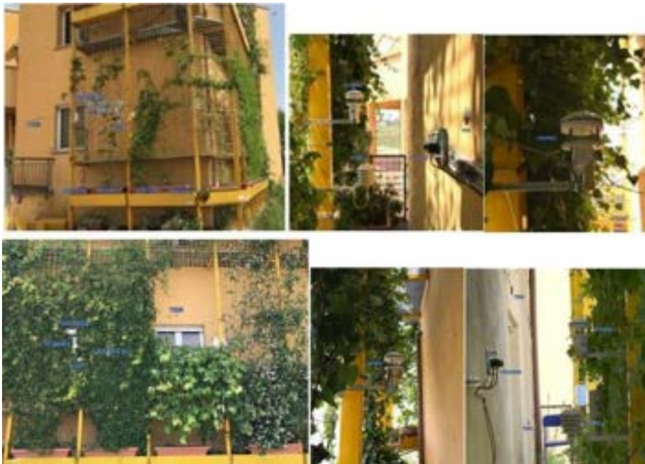
Figura 4. Immagine complessiva con disposizione anemometri
