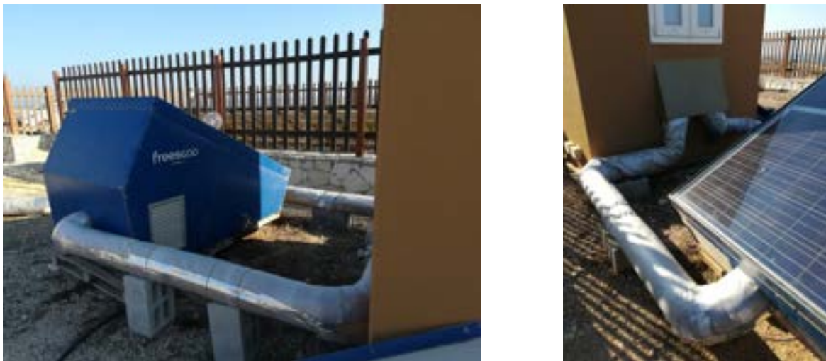
Figura 48 Foto delle canalizzazioni dell’aria dopo il ripristino
