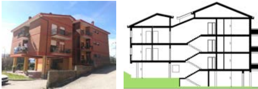
Figura 1 – Fabbricato ATER Anagni 18B
