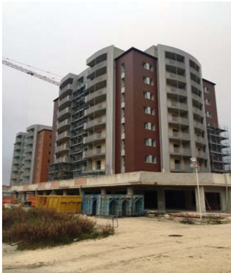
Figura 4. Edificio considerato come riferimento.
