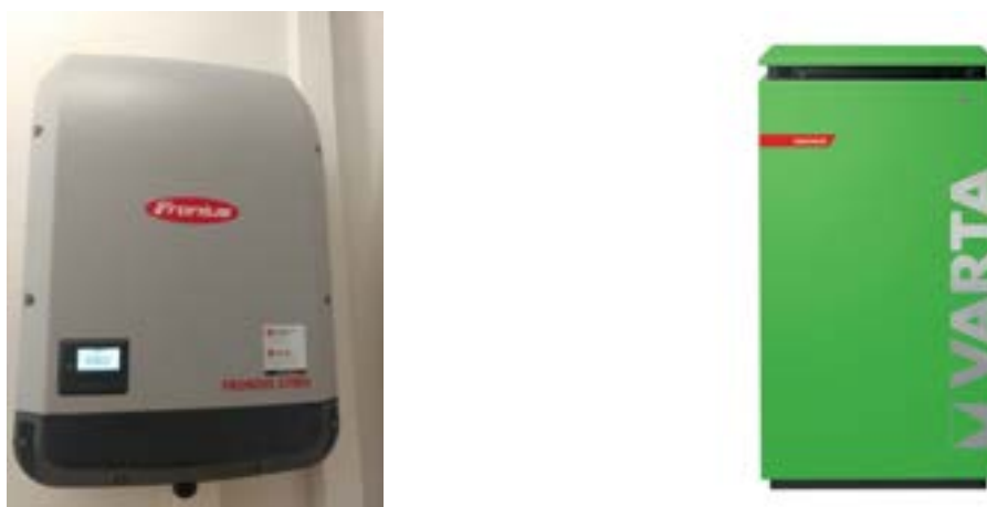
Figura 108. Inverter dell'impianto fotovoltaico (a sinistra) e batteria d'accumulo fotovoltaico (a destra) presenti nel laboratorio domotico.
