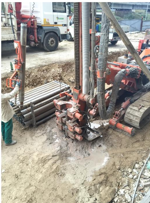
Figura 25. Fotografia dell'infilaggio di una sonda nel terreno.
