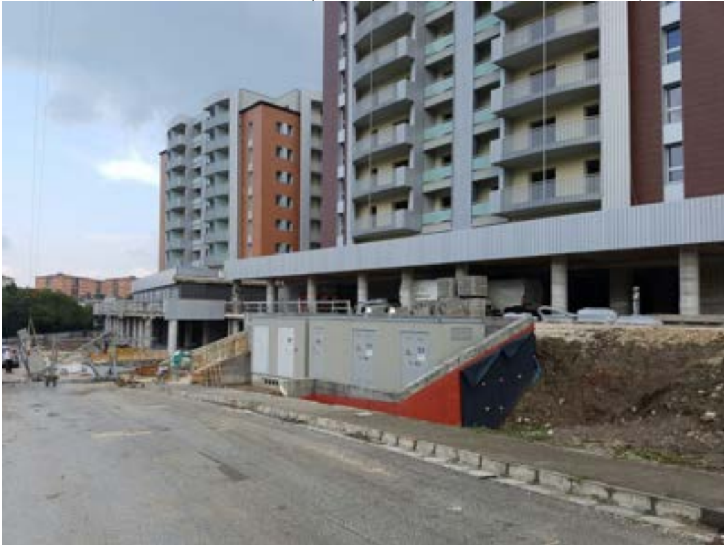
Figura 36. Cabina di consegna e di trasformazione.
