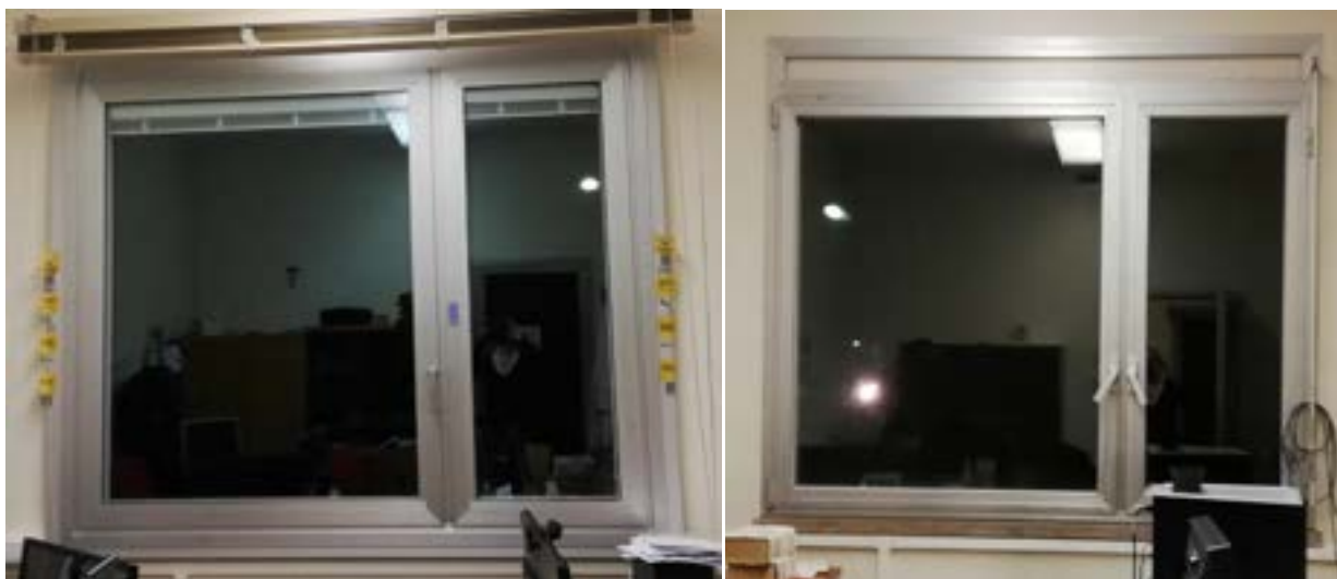
Figura 11 - Nuovo serramento installato, sinistra, e vecchio serramento
