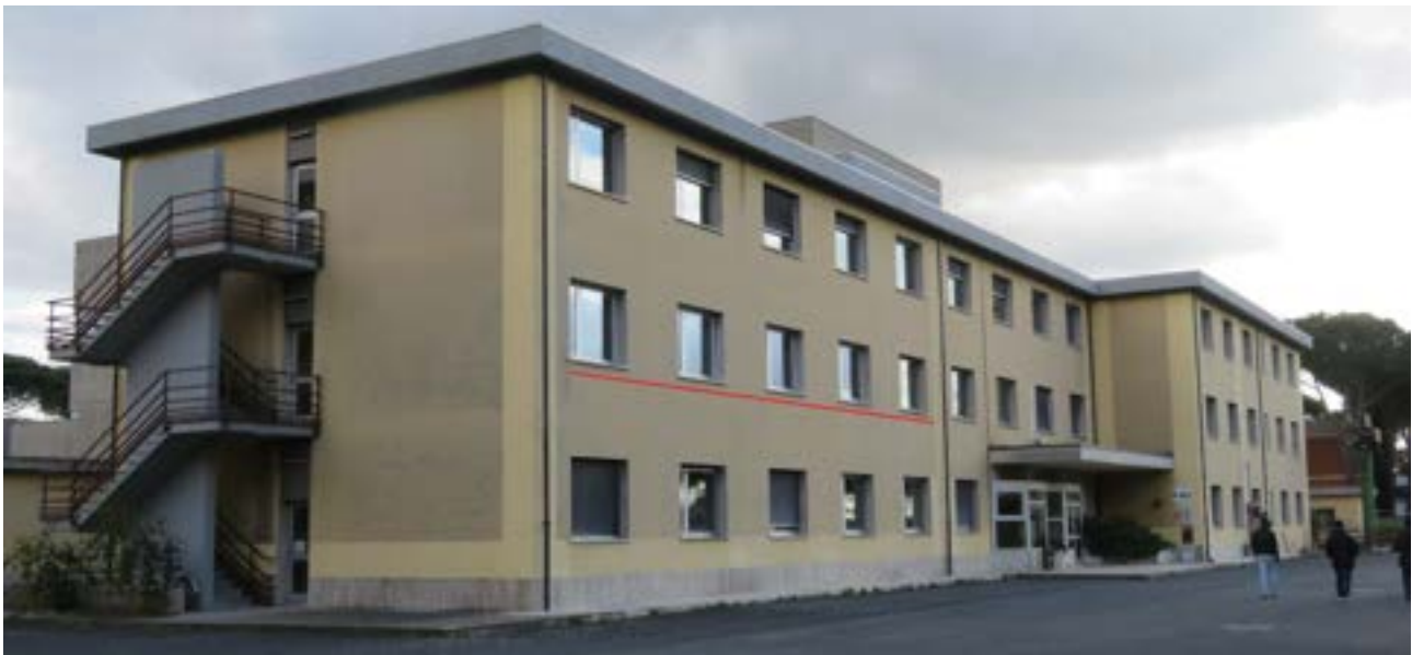
Figura 10 - L'edificio F40 di Casaccia, oggetto dell'intervento
