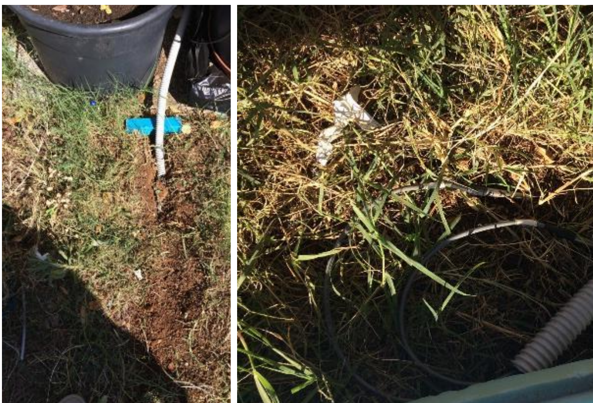
Figura 13: Due termistori per la misurazione della temperatura del terreno antistante la parete.
