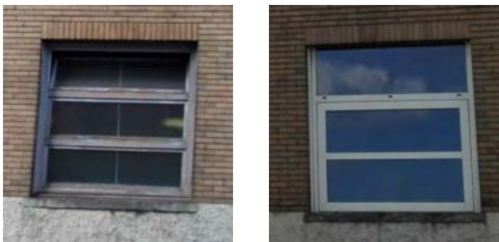
Figura 4.8. Particolare infissi (in legno e vetro singolo a sinistra, in alluminio e vetro doppio a destra).
