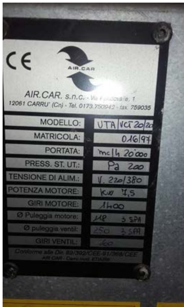
Figura C.7. Caratteristiche tecniche UTA palestra esterna 16
