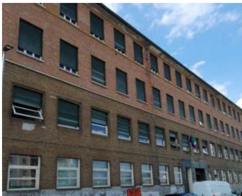
Figura 4.6. Prospetto principale su Corso Venezia
