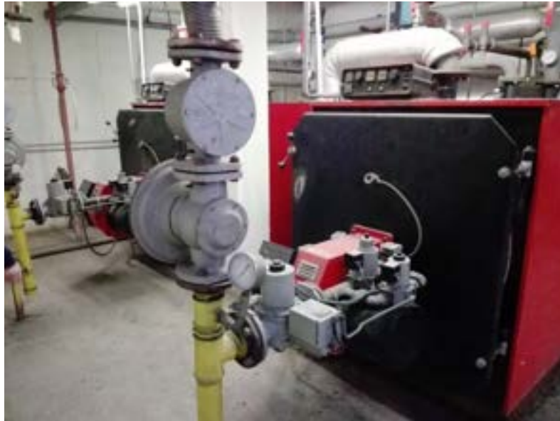
Figura 4.9. Locale centrale termica
