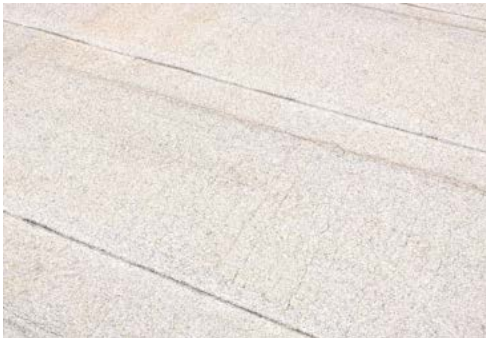
Figura 130: Attuale finitura della copertura a terrazza
