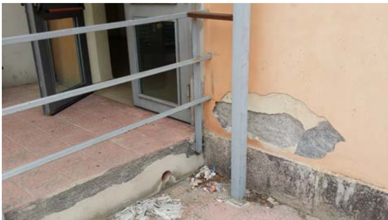
Figura 118: Stato di conservazione esterno
