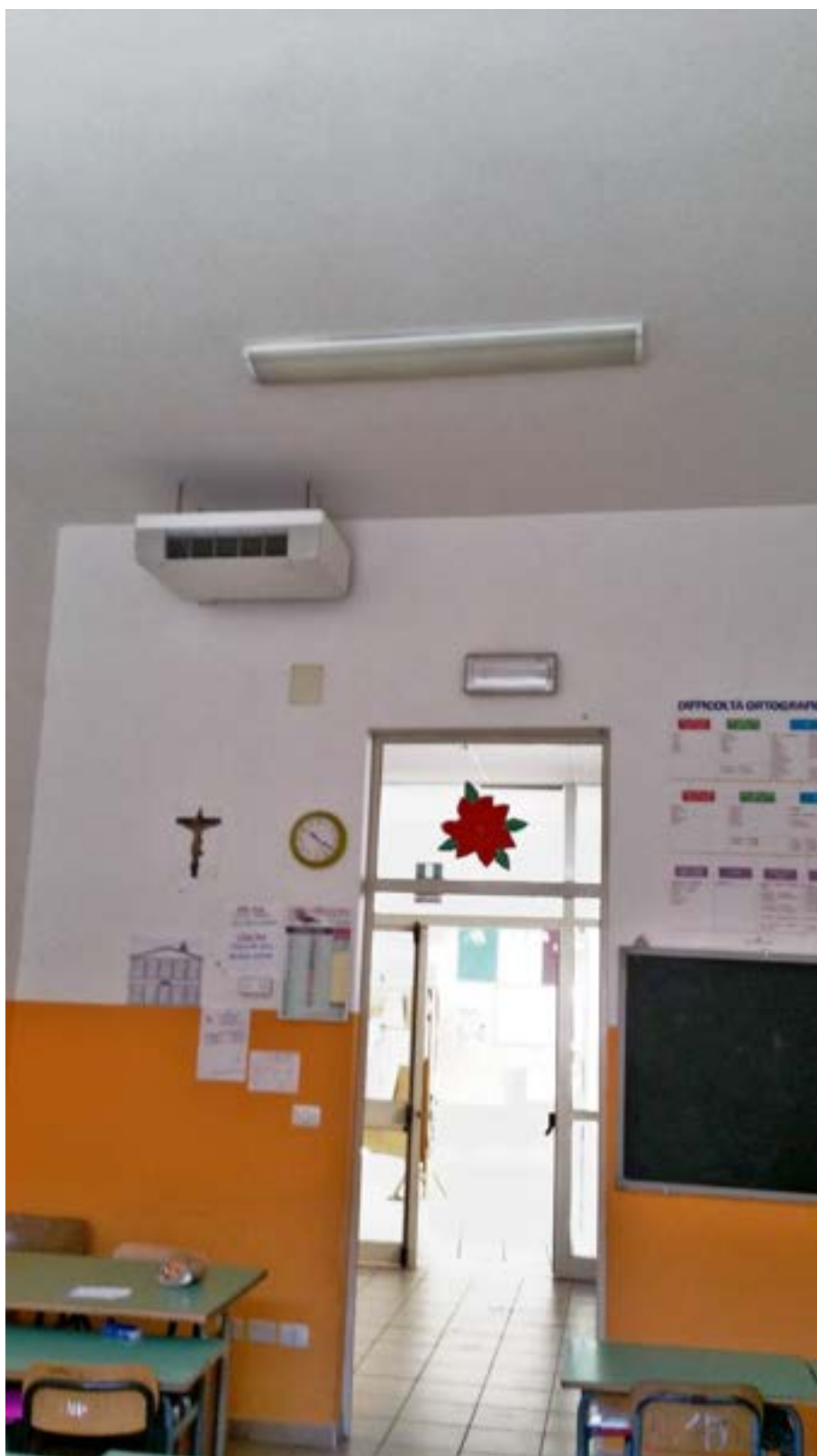
Figura 120: Interno dell'aula 1 a piano terra
