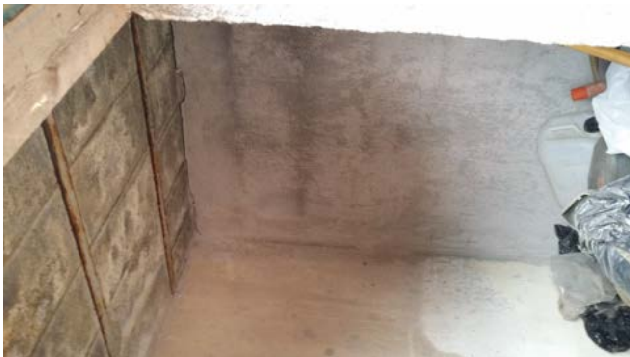
Figura 119: Stato delle murature esterna
