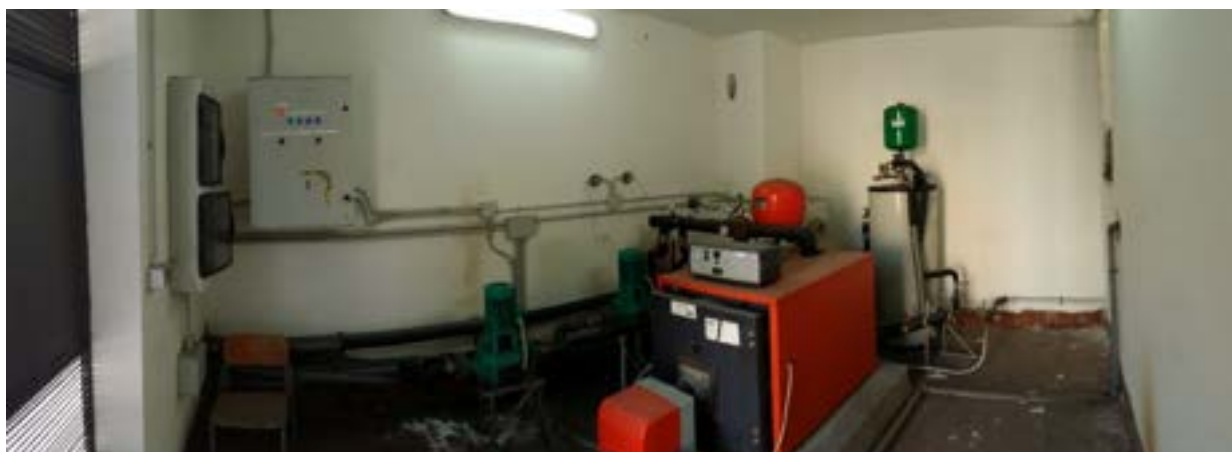
Figura 158: Generatore termico
