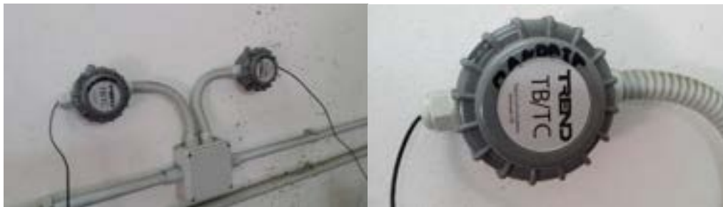
Figura 20: Sonde nelle tubazioni
