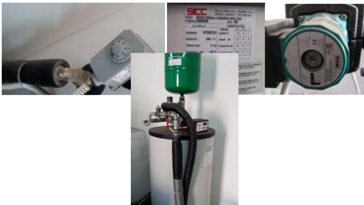
Figura 30: Sistema di accumulo dell'acqua calda
