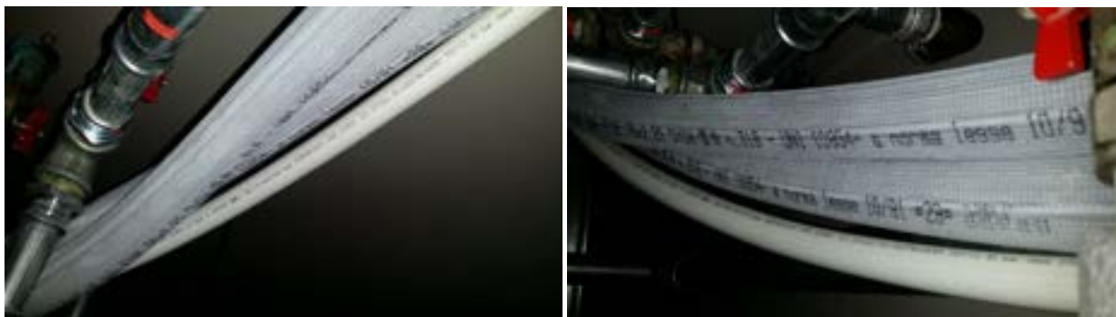
Figura 24: Coibentazione della tubazioni
