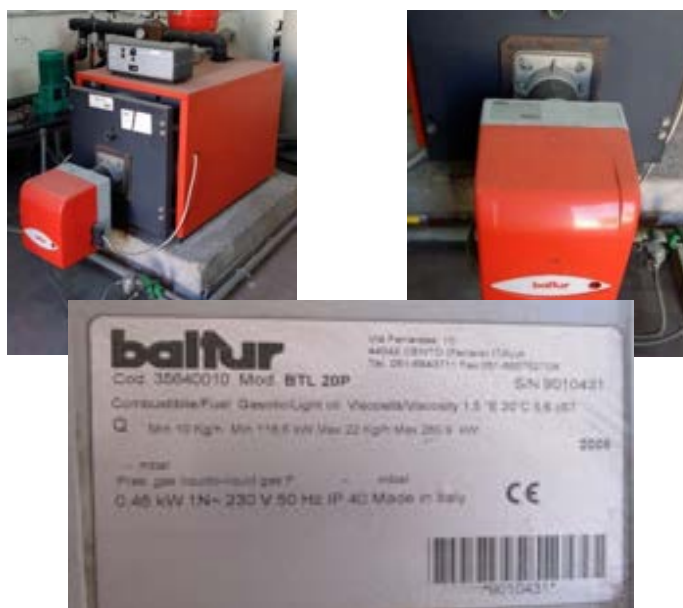
Figura 14: Caldaia e dati di Targa
