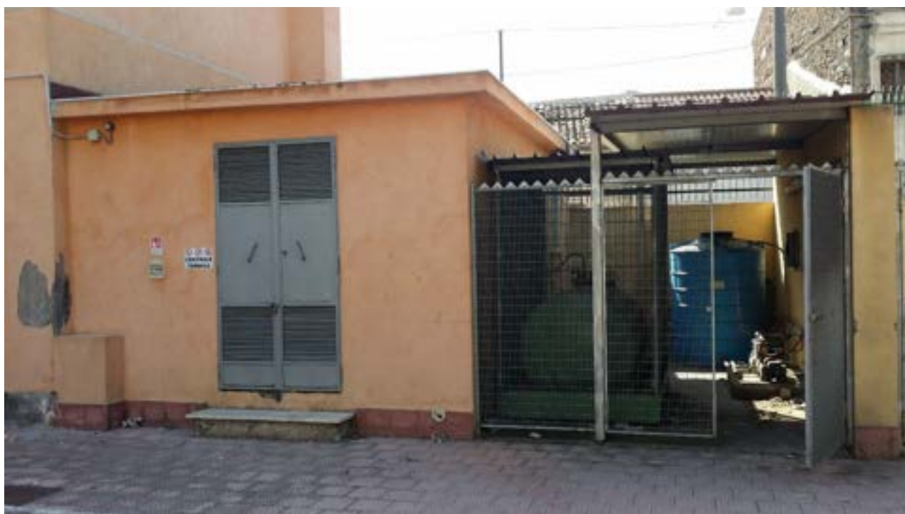
Figura 155: La centrale termica e l'autoclave
