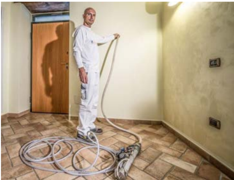
Figura 124: Inserimento della schiuma isolante
