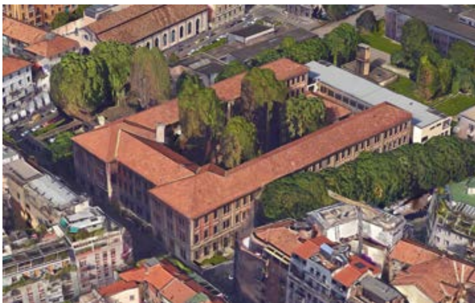
Figura 3. Vista dell'edificio da Sud – Ovest.
