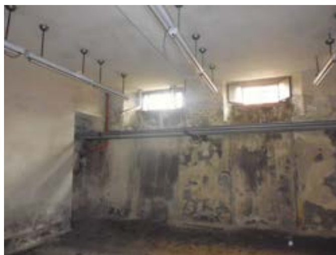
Figura 8. Particolare piano interrato.
