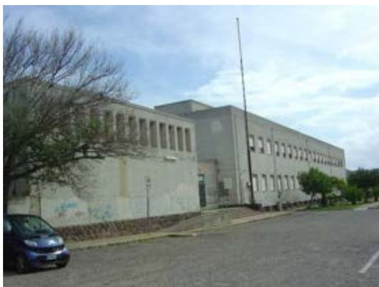
Figura 17. Scuola Sebastiano Satta di Carbonia - Vista Corpo centrale (via della Vittoria)
