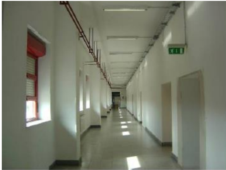
Figura 34. La dorsale di distribuzione del fluido termovettore
