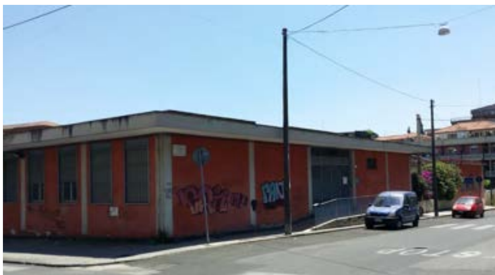
Figura 4. Retro dell'edificio, prospetto ovest (Via Antonio Gagini)
