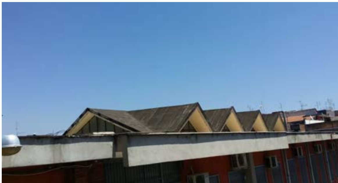
Figura 12. Copertura del lucernario sul corridoio
