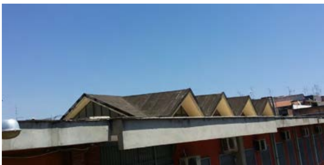
Figura 60. Copertura esistente del lucernario sul corridoio
