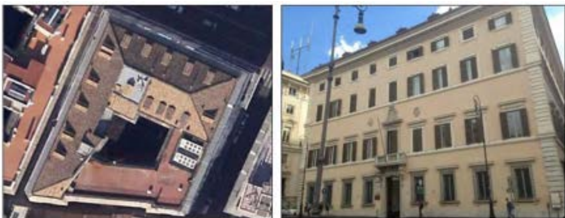
Fig. 3: Vista del perimetro esterno di Palazzo Baleani
