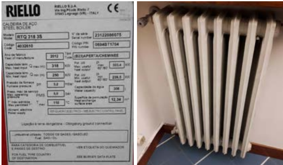
Fig. 5: Caratteristiche termiche Caldaia (sinistra) e esempio di radiatori presenti (destra)
