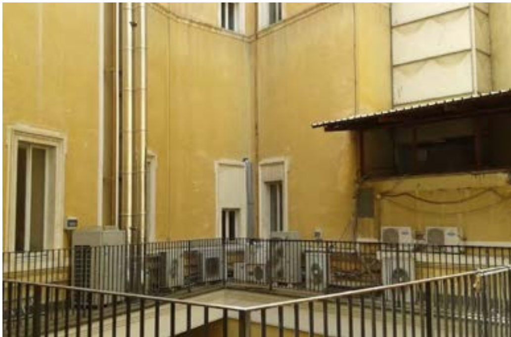
Fig. 6: Unità Esterne climatizzazione
