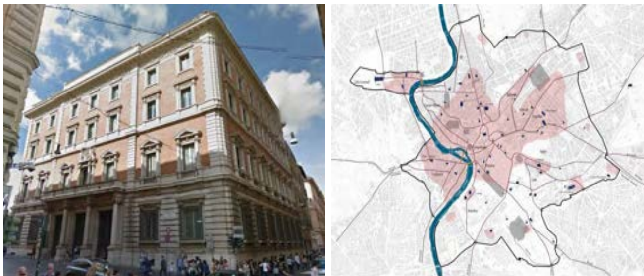
Figura 8.1 – Vista dell'edificio e ubicazione
